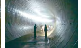
地下トンネル(直径13m)
